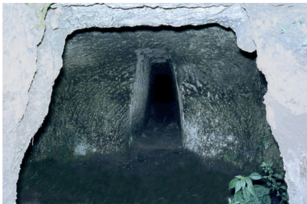
Fig. 110. Civita, versante occidentale: cunicolo con vasca per la captazione e la raccolta delle acque (da TAMBURINI 2007a).
