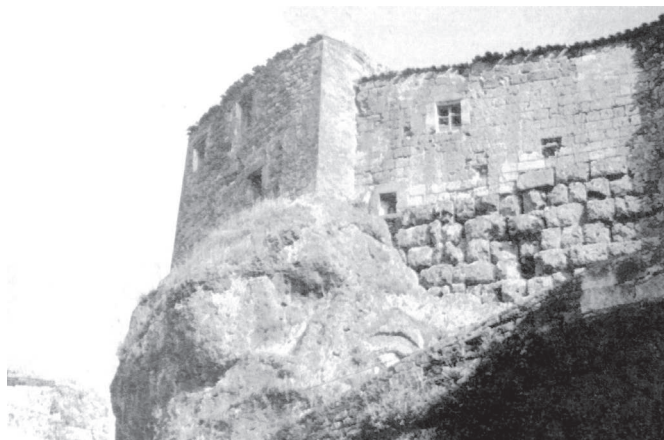
Fig. 62. Pitigliano: resti della cinta muraria etrusca in opera quadrata al di sotto delle mura medievali, presso Porta di Sotto (da PELLEGRINI 2006).
