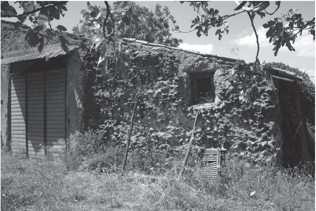
Fig. 14. Capodimonte, fosso della Nocchia: resti di una cisterna riferibile alla Visentium romana, riutilizzata in epoca moderna (da Rossi 2012).
