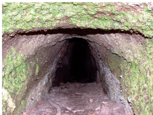
Fig. 142. Civita d'Arlena, versante occidentale: cunicolo con vasca per la captazione e la raccolta delle acque. (TAMBURINI 1998).
