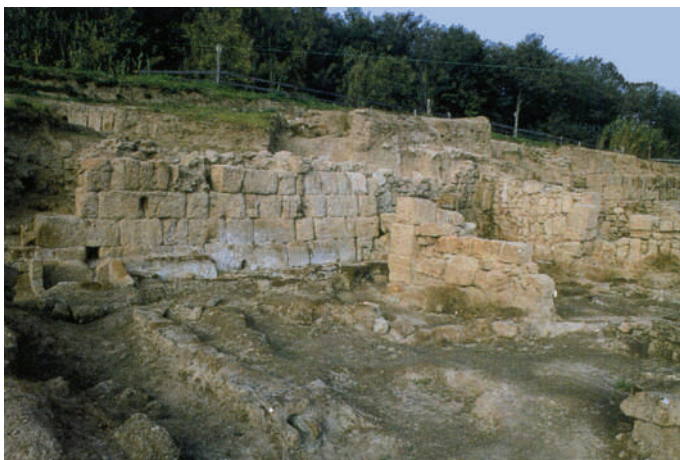
Fig. 174. Orvieto, santuario di Cannicella: veduta del muro di temenos in opera quadrata (da RONCALLI, STOPPONI 1998).
