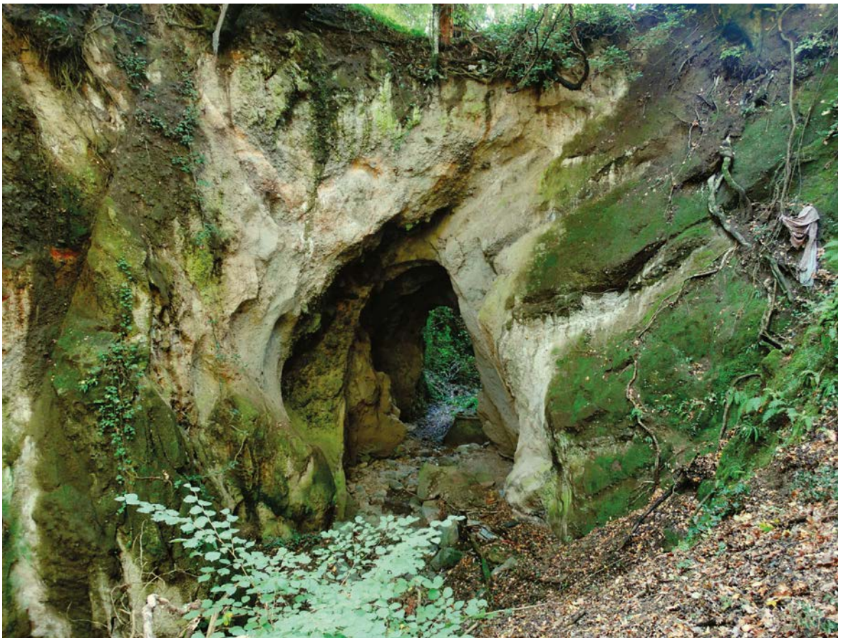
Fig. 7 – Il Ponte Sodo.
